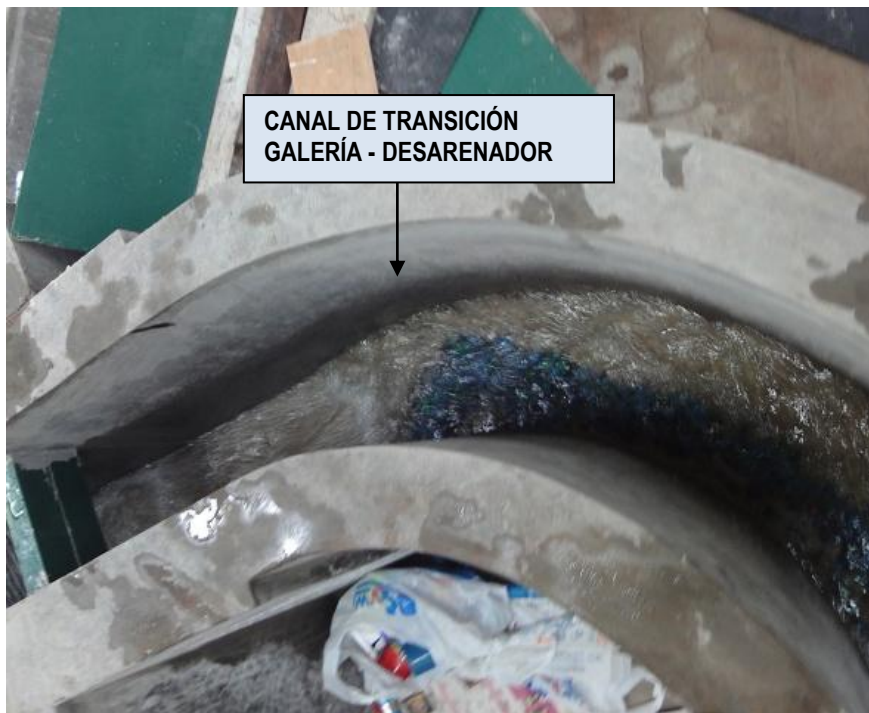
Fotografía 6.9. Canal de transición (tomado por: Herrera Diego)
