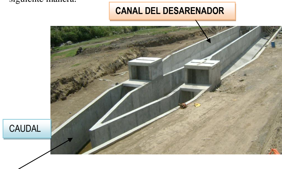
FOTOGRAFÍA 3.1. Desarenador doble del río Boquerón (Elaborado por Herrera Diego)
