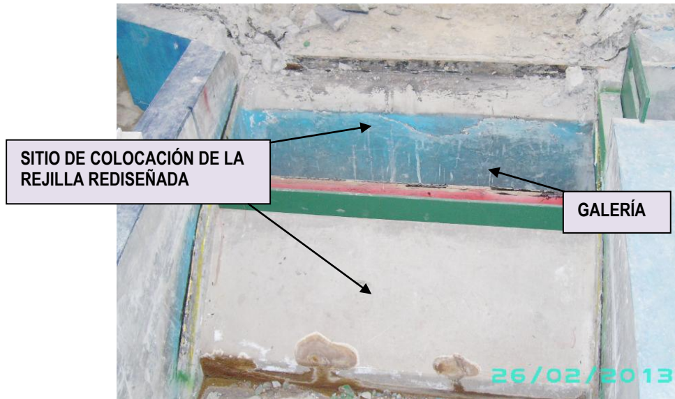
Fotografía 5.4. Cambio de barrotos de la rejilla (tomado por Herrera Diego)
