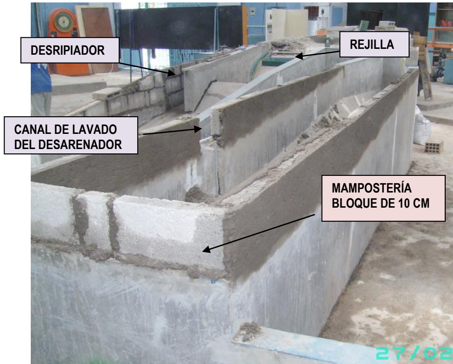
Fotografía 5.2. Mampostería de confinamiento conformada por unidades de bloque alivianado prensado.(tomado por: Herrera Diego)
