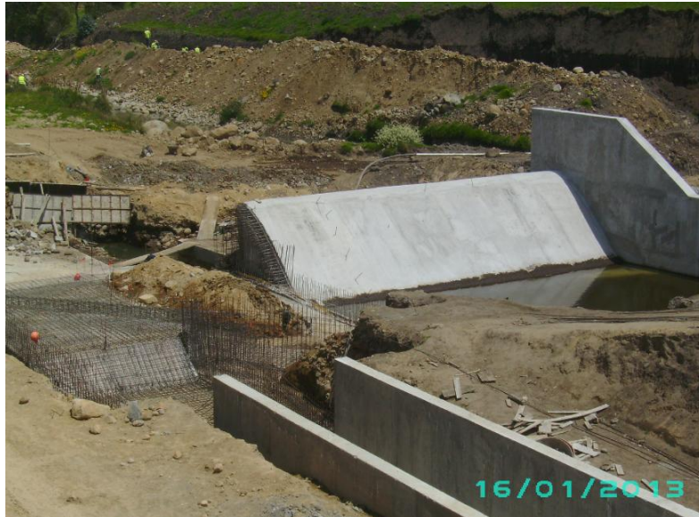
FOTOGRAFÍA 1.1. Construcción del proyecto (tomado por Herrera Diego)
