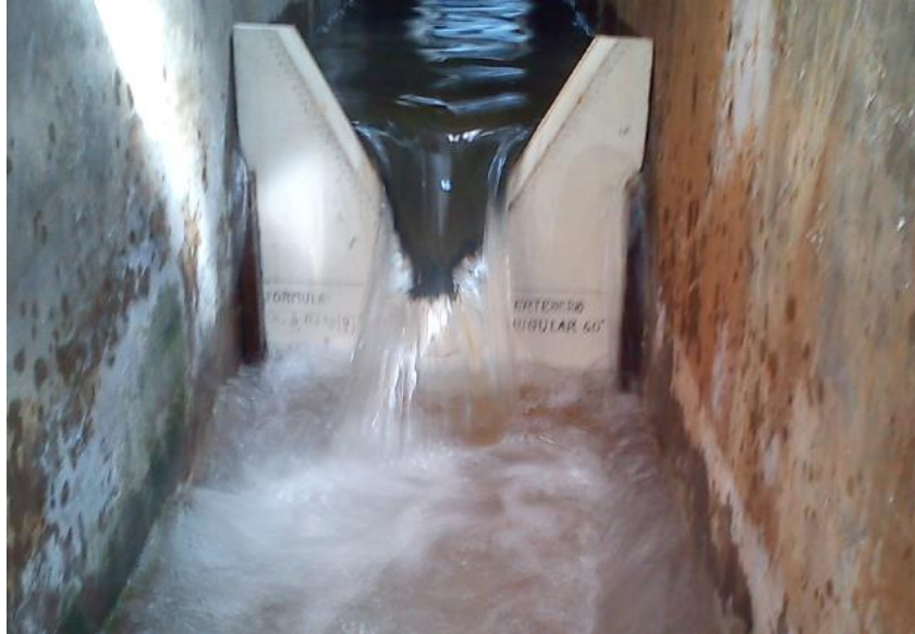
Fotografía 5.8. Vertedero triangular de 60° (tomado por: Herrera Diego)
