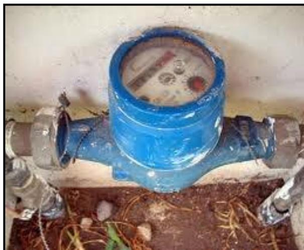
Ilustración 2: Medidor de Agua Potable
