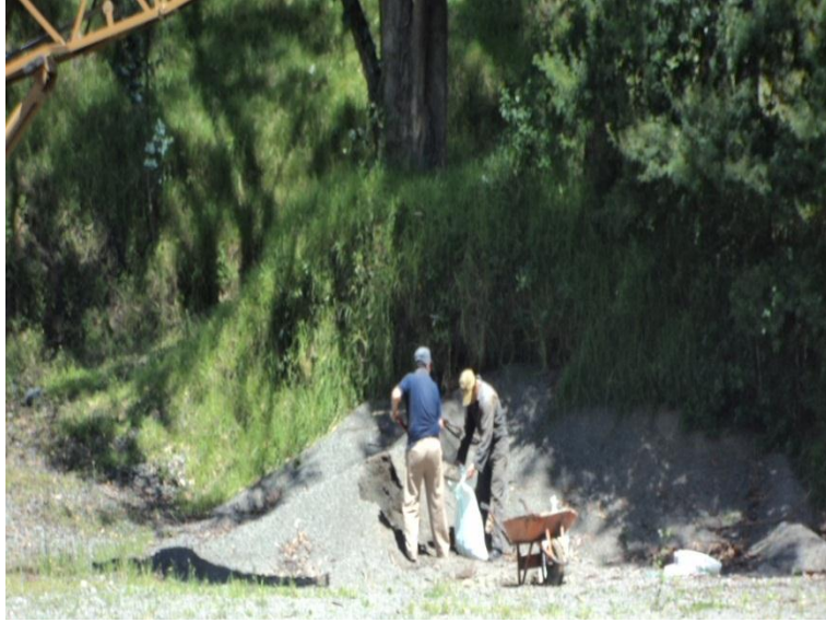
Fotografía 3. 3: Toma de muestra del agregado de la pila de acopio
