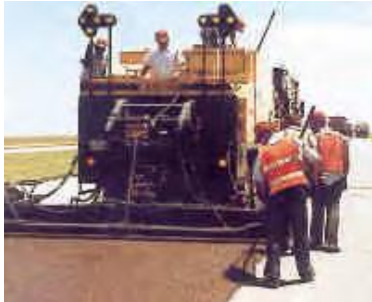
Figura 1. 1: Colocación del micro pavimento
