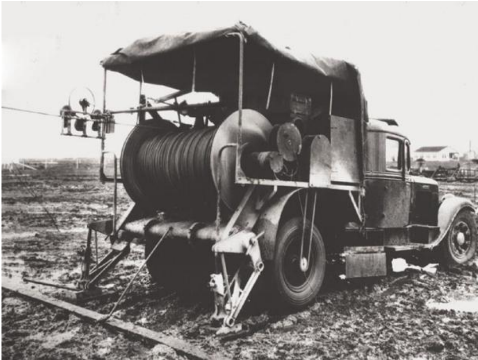
Fig. 24. Camión de registro de Schlumberger en la década de 1940.
