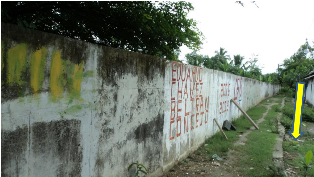
Ilustración 14. Muro de Contención
