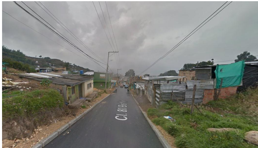
Figura 14. Estado actual barrio Compostela 3
