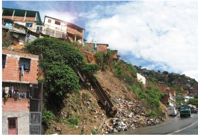
Figura 37. Estado actual botadero de basura borde occidental
