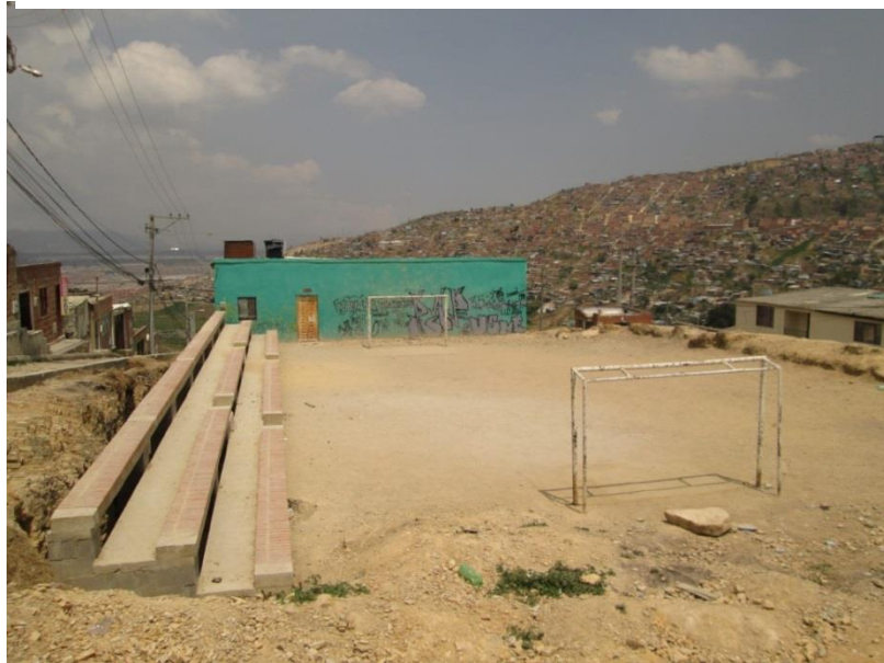
Figura 17: Vista frontal del salón comunal y cancha
