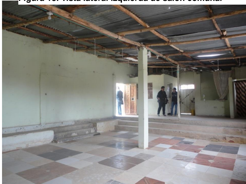
Figura 18: vista lateral izquierda de salón comunal
