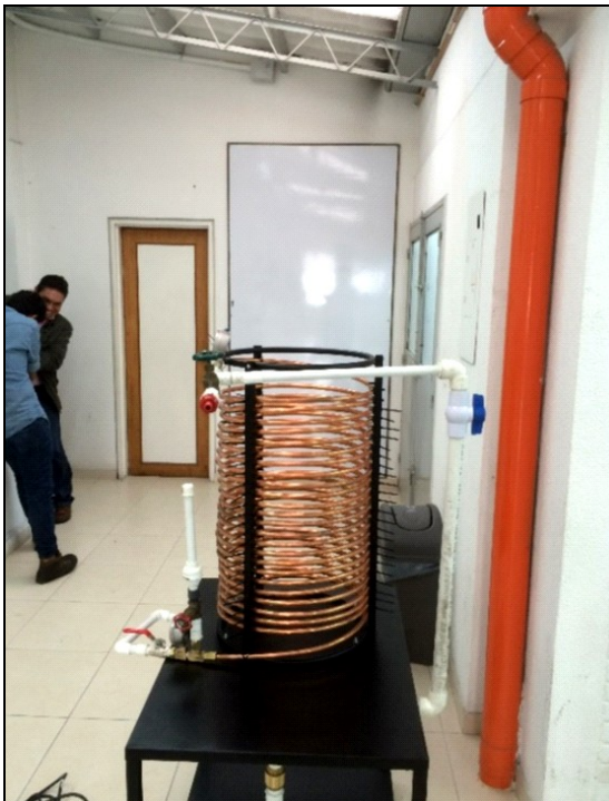
Figura 21. Instalación 2 tubería PVC.
