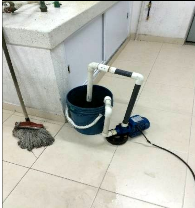
Figura 14. Montaje prueba bomba.
