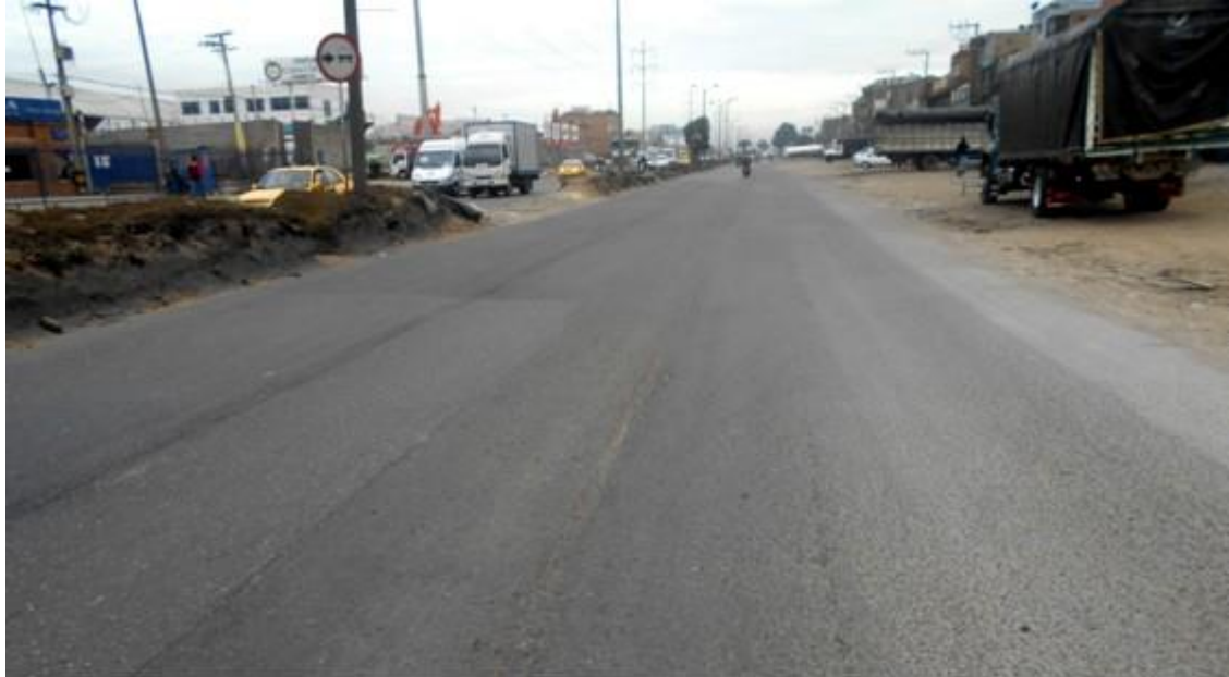
Figura 7. Demarcación vial existente.
