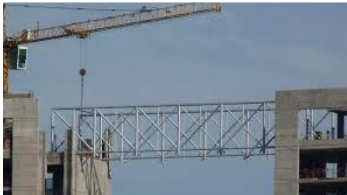
Figura 4. Construcción de viga Vierendeel.
