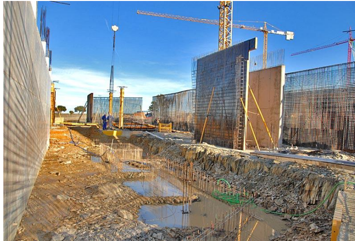
Figura 3. Construcción con muros pantalla.
