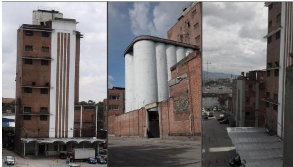
Figura 20. Estado actual de las edificaciones
