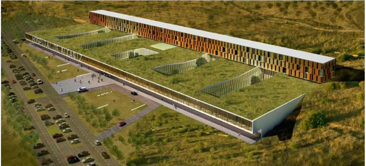
Figura 10. Nuevo Hospital de Alcañiz
