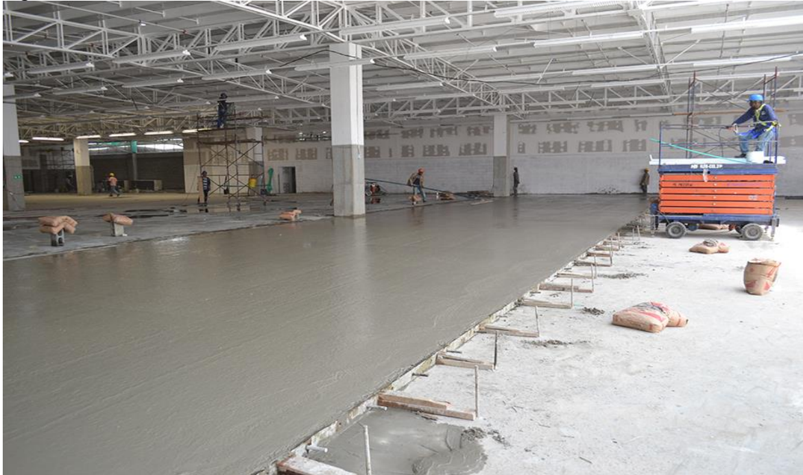
Figura 4. Elaboración de un piso industrial
