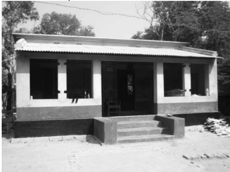
Figura 10. Vivienda rural con plinth cercana a la ciudad de Dacca, Bangladesh
