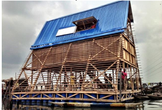
Figura 2. Estructura sostenida en canecas plásticas
