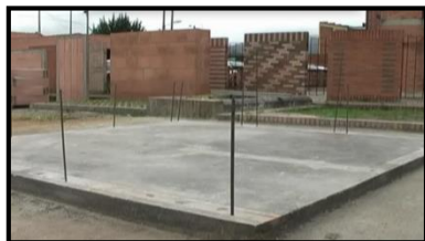
Figura 1. Placa de cimentación.
