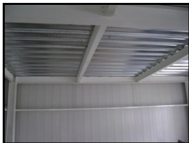
Figura 44. Instalación lamina colaborante.
