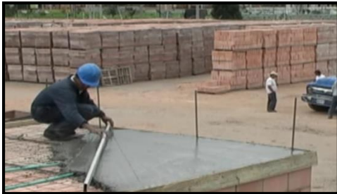
Figura 6. Instalación concreto losa entre piso.
