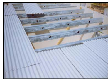
Figura 38. Instalación de correas.
