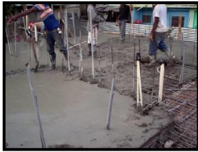
Figura 14. Construcción de cimentación.
