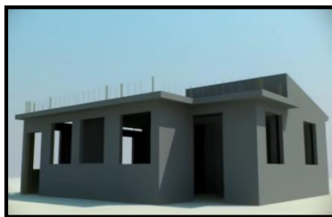
Figura 12. Muros terminados y arranques para segundo nivel.
