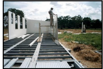
Figura 16. Instalación de muros.
