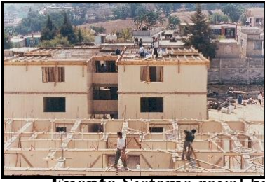
Figura 42. Alistado placa segundo nivel.
