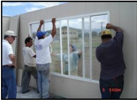
Figura 49. Instalación de ventaneria
