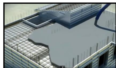
Figura 11. Instalación de concreto para muros y placa.
