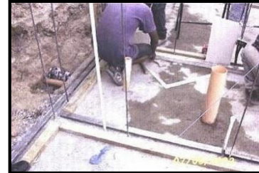
Figura 15. Replanteo de muros e instalaciones eléctricas e hidrosanitarias.
