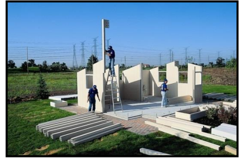
Figura 31. Instalación de muros.
