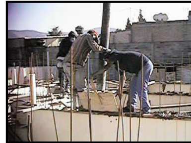
Figura 36. Fundida relleno muros.
