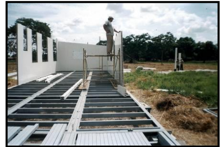
Figura 32. Instalación de muros.
