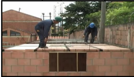
Figura 5. Instalación de prefabricado para placa entre piso.
