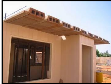
Figura 43. Instalación de losa entreplazo placa bloquelon.
