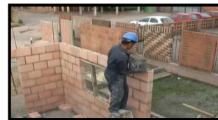
Figura 4. Instalación de groutin.
