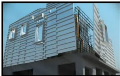
Figura 13. Armado y formateado de muros segundo nivel.
