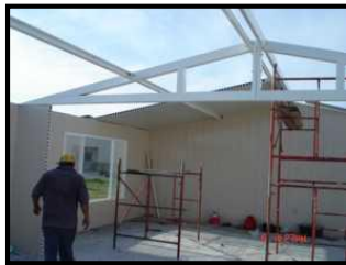
Figura 17. Instalación de correas para cubierta.
