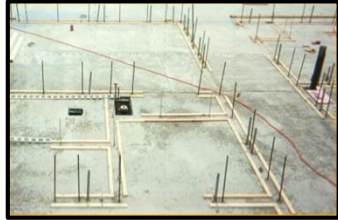
Figura 30. Replanteo de muros e instalación de refuerzo.
