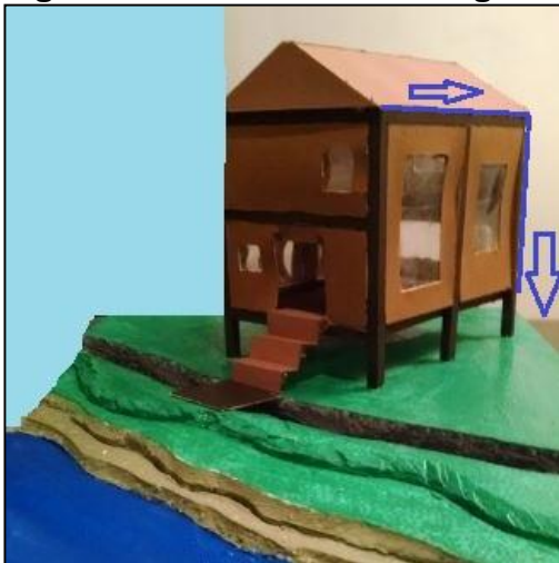
Figura 16. Conducción de Aguas Lluvias por Canaletas
