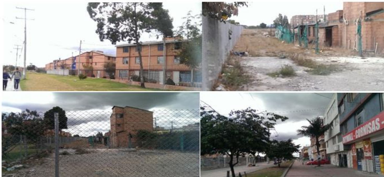
Figura 24 “Barrio Villas de Granada. Edificaciones”
