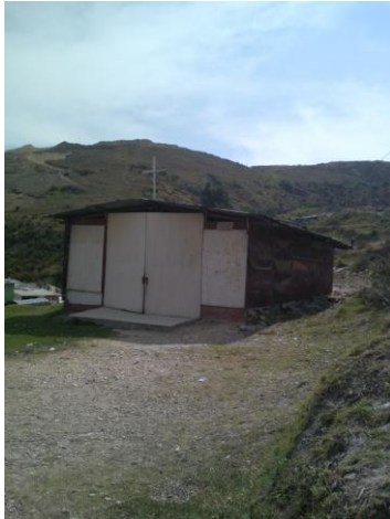
Figura n°3 - (Izq.) Iglesia (Der.) Volúmenes Colegio
