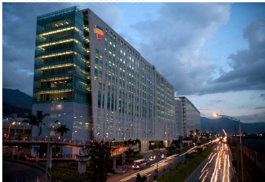
Figura 32. Edificio Bancolombia sede Medellín.
