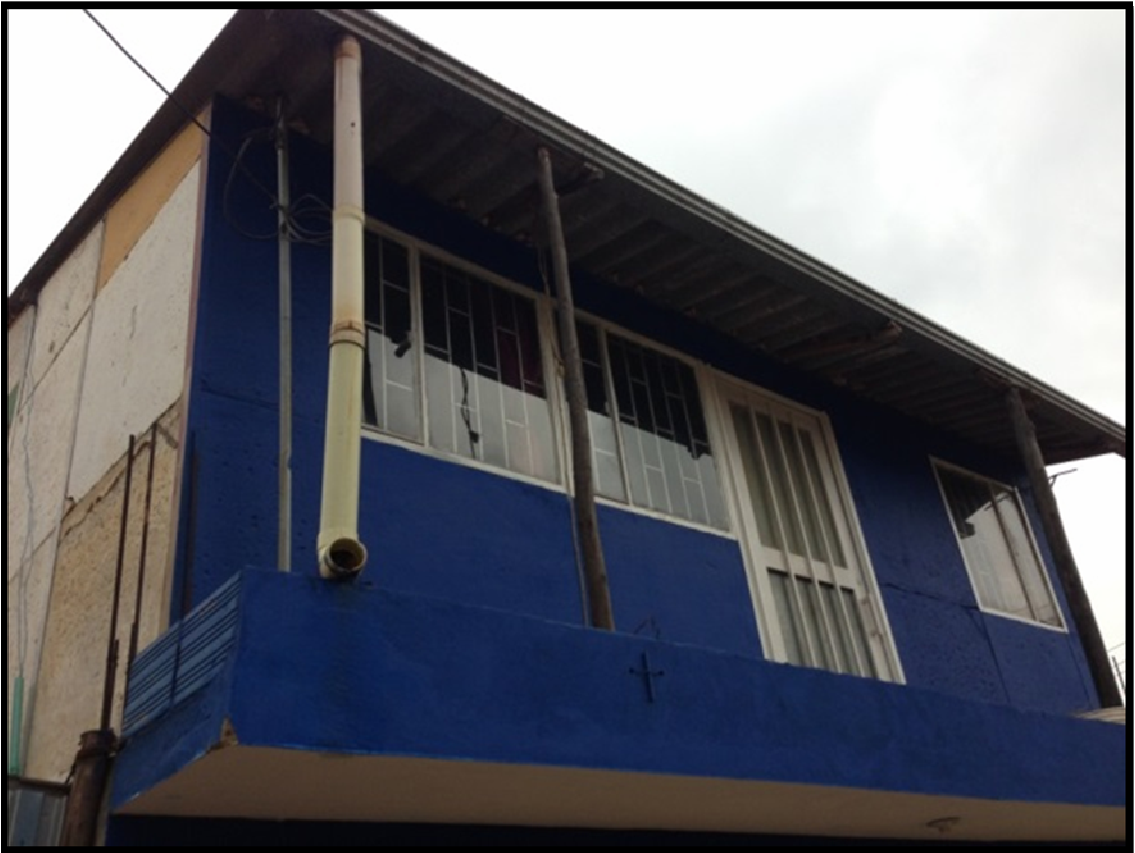
Figura 12. Drenaje actual de aguas lluvias.
