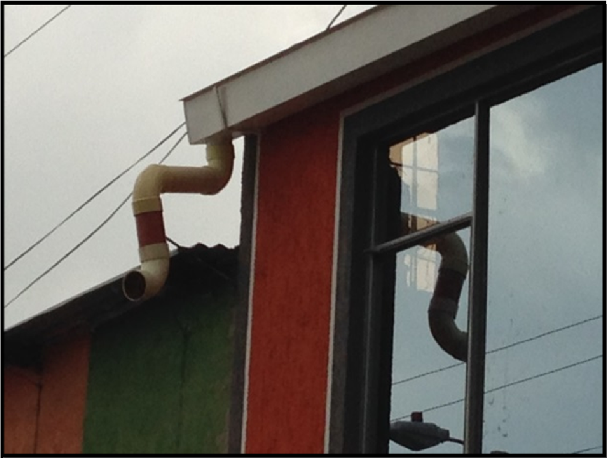
Figura 11. Drenaje actual de aguas lluvias.
