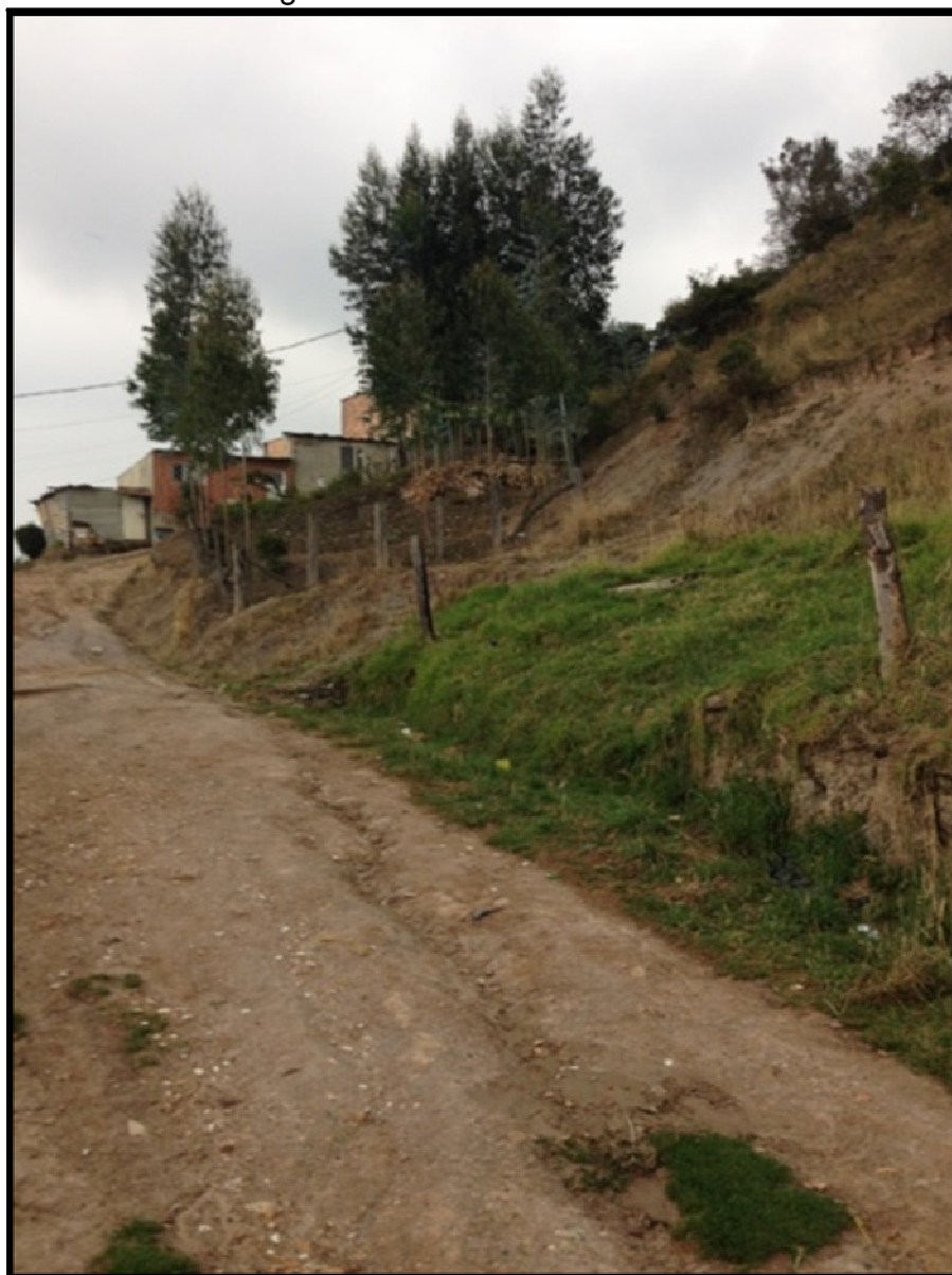
Figura 14. Sector de alto riesgo.
