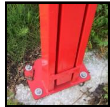
Anclajes en concreto Mexico /(2014)
