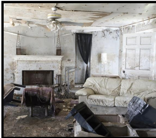
Figura 2. Estado de la sala de una vivienda después de la inundación
