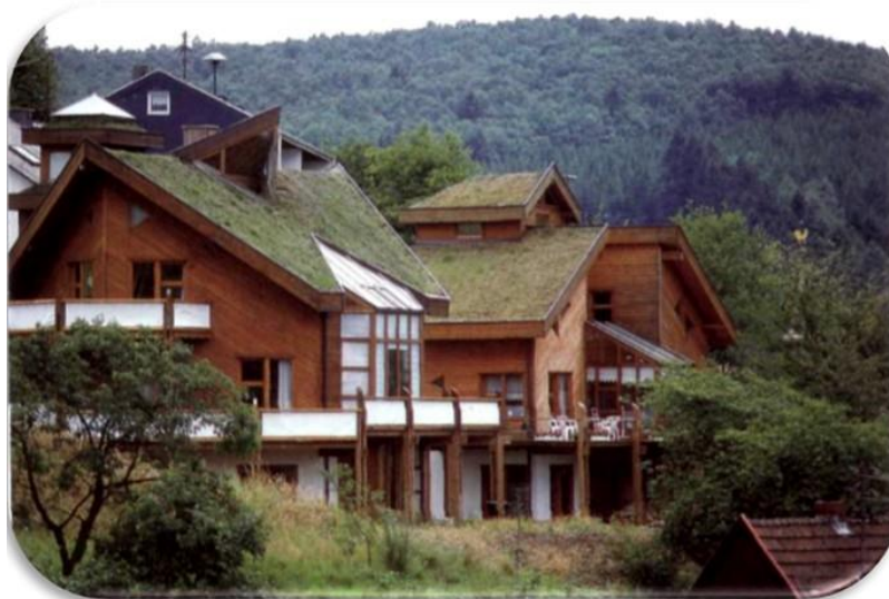
Figura 23. Viviendas de Siegen-Oberscheiden (Alemania).
