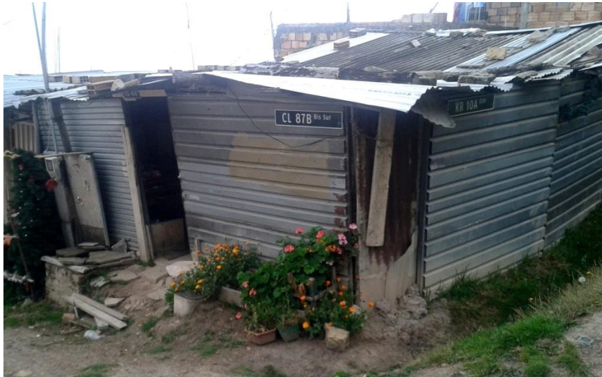
Figura 17. Cubierta de la vivienda visitada.
