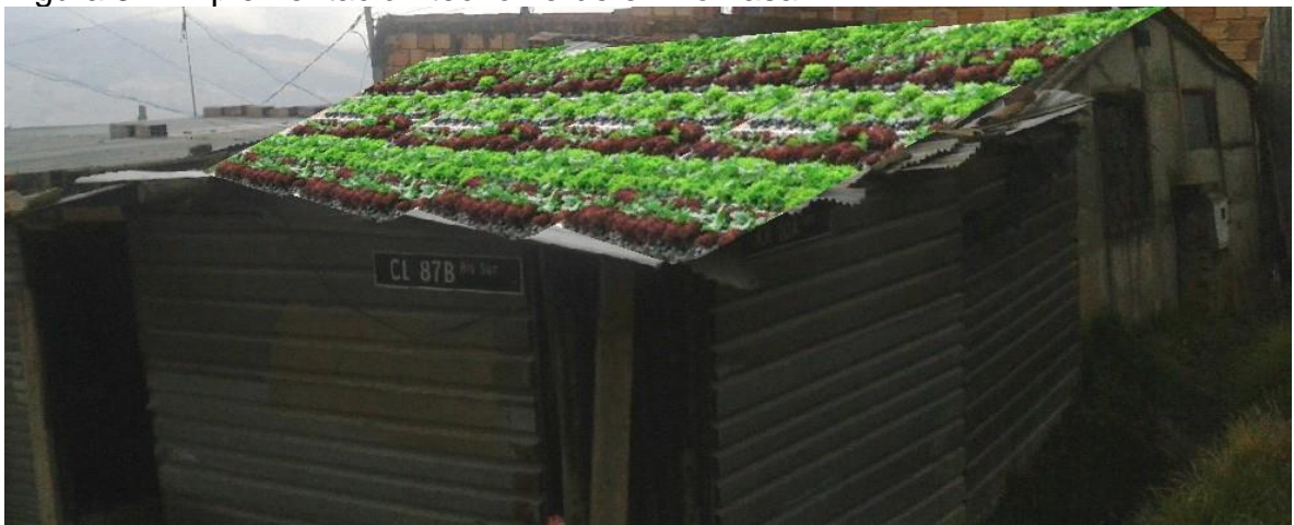
Figura 37. Implementación techo verde en Yomasa
