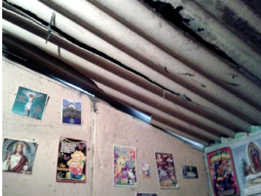
Figura 14. Vista interior de cubierta de vivienda visitada.
