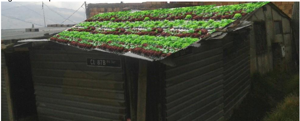
Figura 39. Implementación techo verde en Yomasa.
