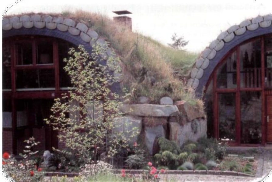
Figura 21. Vivienda ubicada en Dortmund (Alemania)
