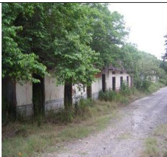
Vía principal del municipio de Armero.
