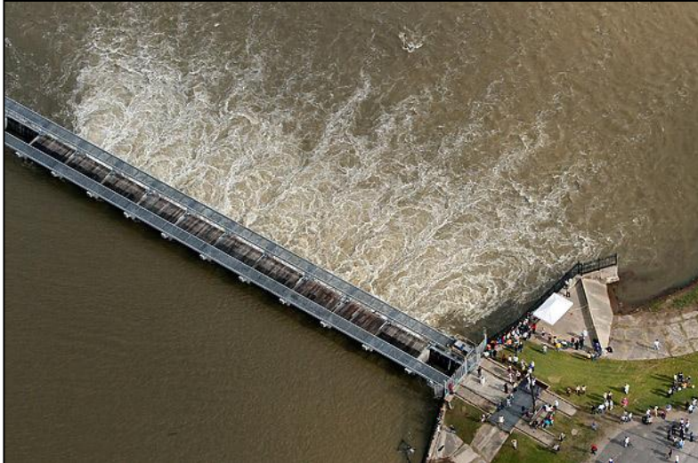
Figura 2. Abertura de Compuertas del Dique Bonnet-Carré en Norco, Louisiana
