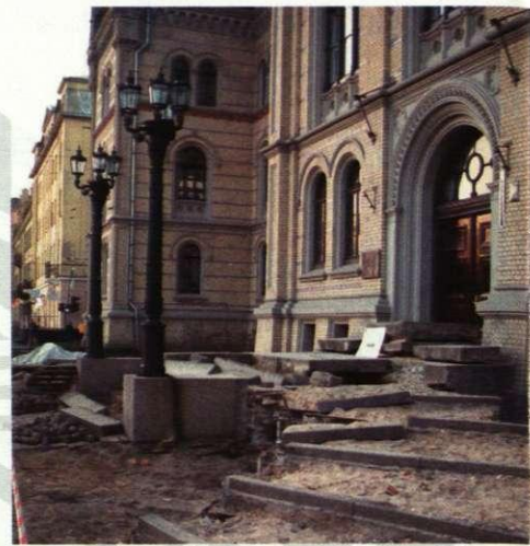
Universitātes galvenās ēkas kāpņu restaurācija. 2000. gads Renovation of the front stairs of the main building of the University, 2000
