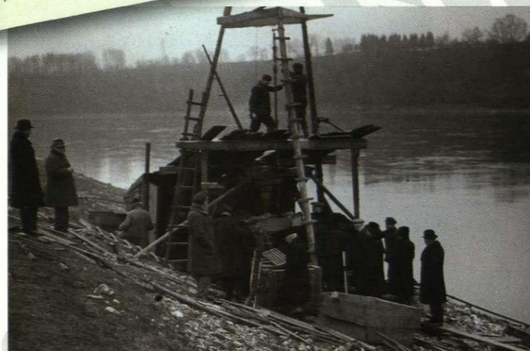
«The Foundation Company» veiktie urbumi iespējamajās Ķeguma spēkstacijas vietās. 1933. gads Boreholes in the possible construction sites of the Ķegums HPP drilled by The Foundation Company, 1933
