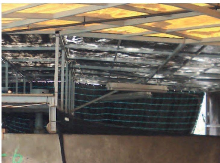
Tanque de reproductores de mero de 50 \text{ m}^3 de volumen, provisto de rebosadero superficial para la recogida de puestas
