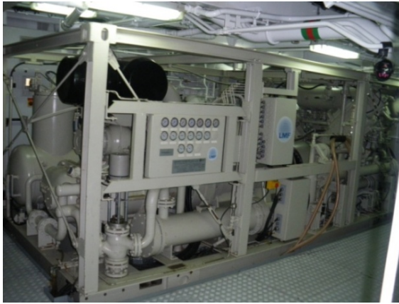
Fotos 1 y 2 . Compresor LMF 25/138-207-E50 instalado a bordo del Sarmiento de Gamboa.
