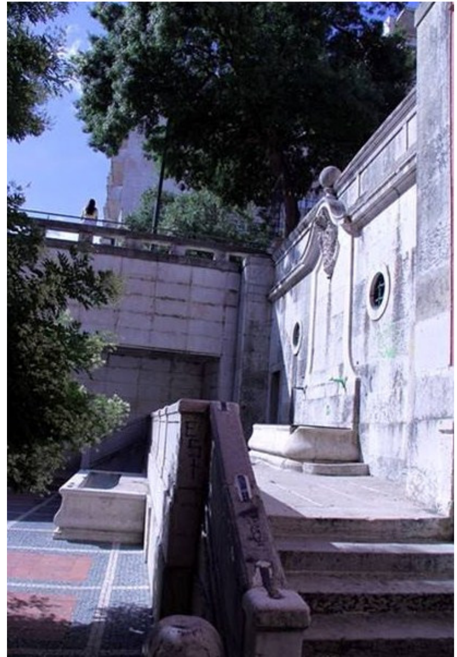
Chafariz do Andaluz (1336)
