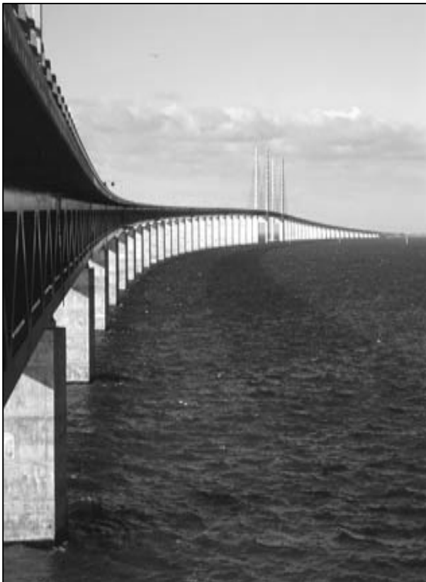
Abb. 10: Die Öresund-Brücke verbindet seit 2000 das schwedische Malmö mit dem dänischen Kopenhagen
