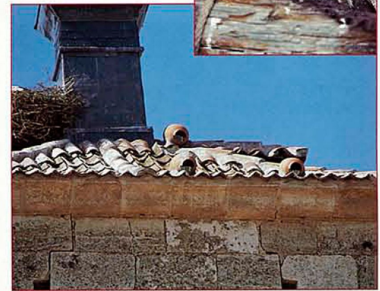
Estos cubículos, fabricados en barro, permiten la nidificación del Cernícalo primilla (en la foto superior)
