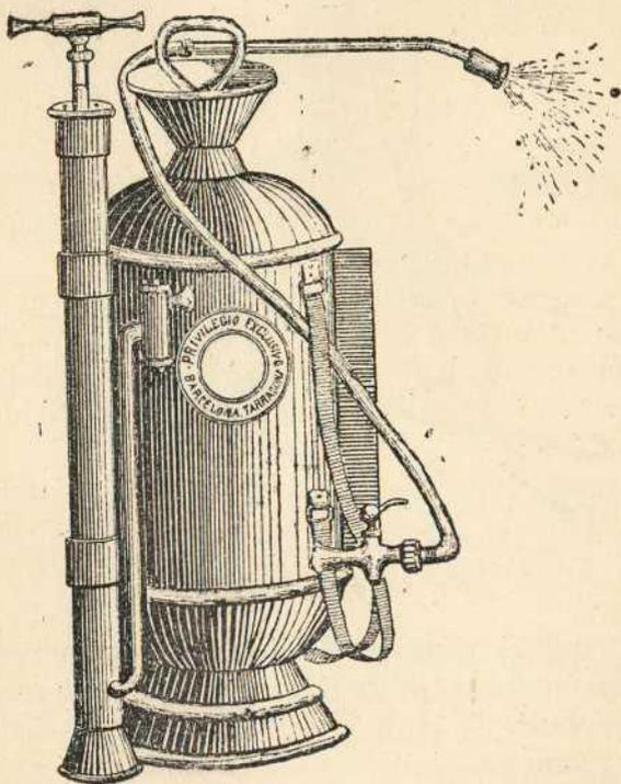
Fig. 15.—Pulverizador Salabert de aire comprimido
