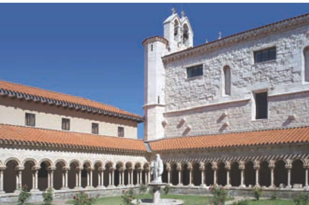
Claustro de Santa María la Real de Villamayor
