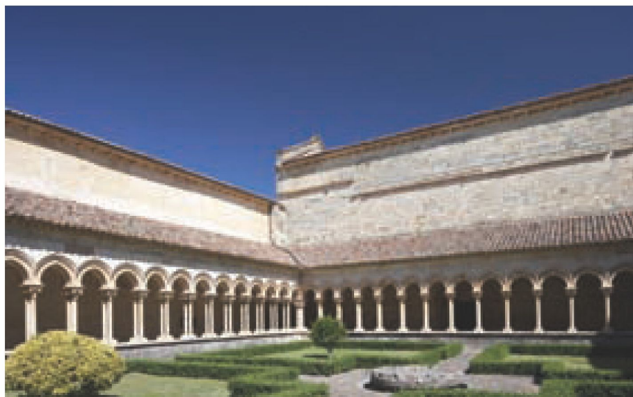
Vista del claustro de San Andrés de Arroyo
