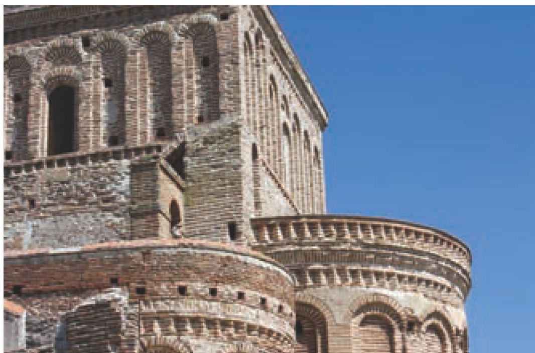
Arquitectura en ladrillo de La Lugareja
