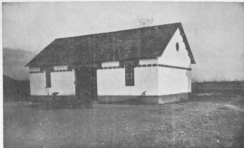
Almacén de Maquinaria
