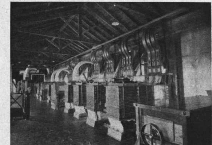
Otro aspecto del interior de una de las modernas Fábricas de Harinas instaladas en la provincia de Burgos por «Establecimientos Morros S. A.»
