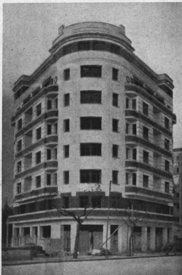
Edificio en construcción (casi terminado) en la calle de Vitoria.
