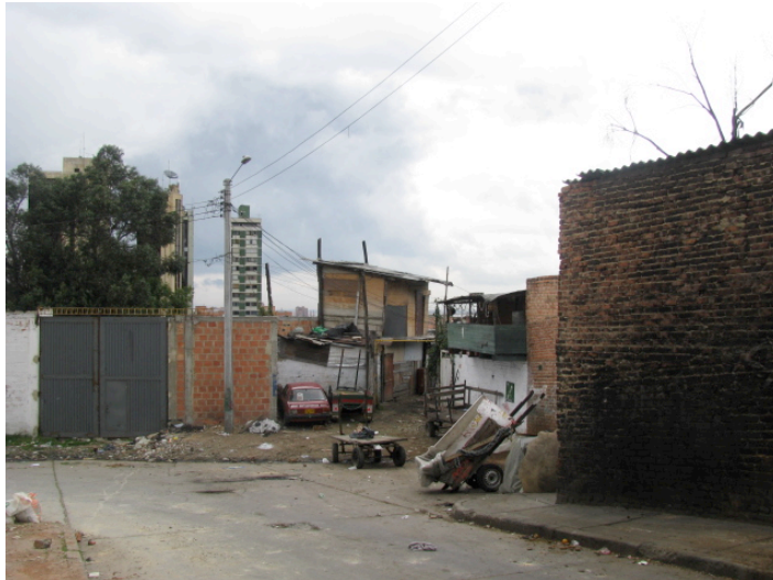
3. Foto del Autor. Vista deterioro de San Martin.
