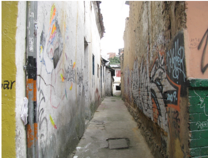
2. Foto del Autor. Vista deterioro de San Martin.
