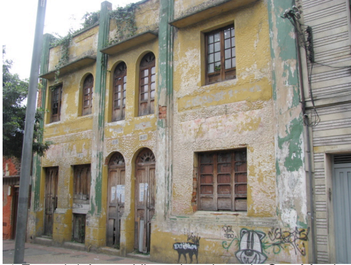
1.Foto del Autor. Vista deterioro de San Martin.
