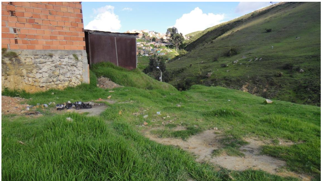
Ciudad Bolívar-Barrio caracolí - Estado de la cimentación
