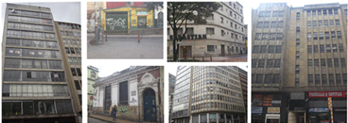
Fig. 34 Abandono y deterioro
