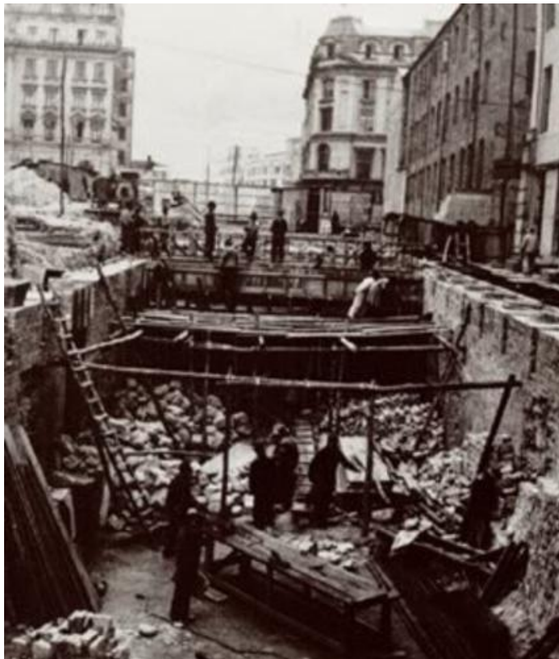
Fig 10. Canalización del Rio San Francisco
