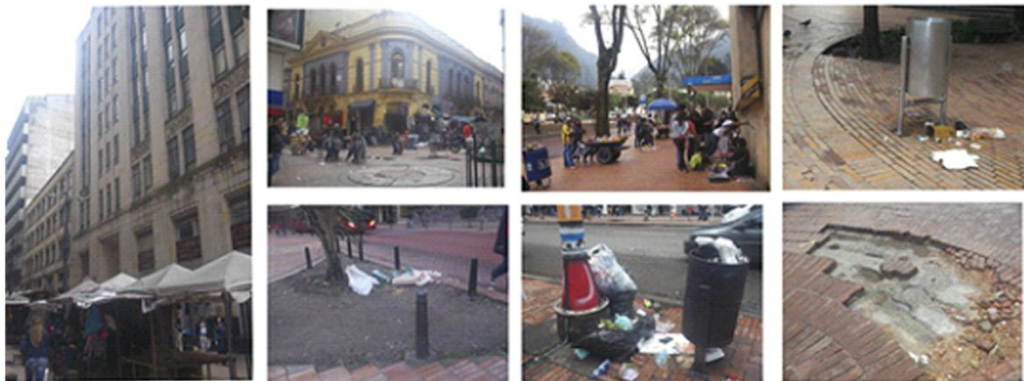
Fig. 36 Deterioro del espacio publico
