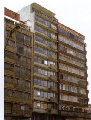
>Edificio Ordóñez. Actualmente registrado como edificio "Ejecutivos". Fachada occidental con frente sobre la carrera Décima. Foto: Carlos Hernández Llamas
