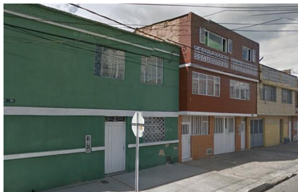
Edificaciones sobre las cuales se hara la reubicacion de viviendas.
