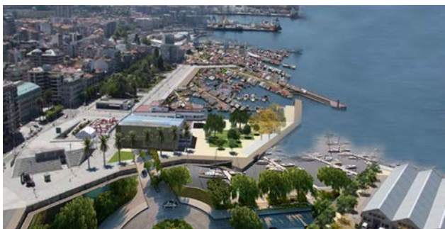
Muelle de transporte municipal
