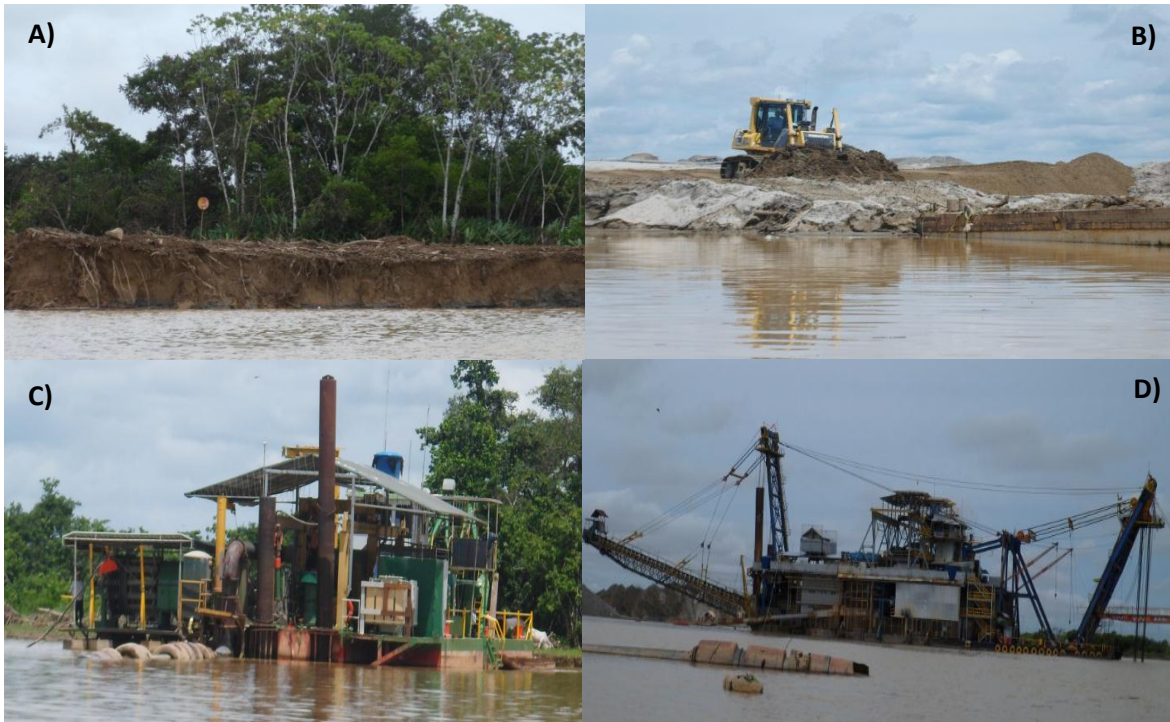
Figura 1. Diferentes momentos del proceso de explotación. Figura A) Fase de descapote y remoción de la cobertura vegetal. Figura B) Reconstrucción morfológica del terreno con retroexcavadora anfibia. Figura C) Draga de succión, que extrae los 10 primeros metros del lecho del río. Figura D) Draga de cuchara, es con la que se extrae el oro entre los 10 y 30 metros de profundidad.
