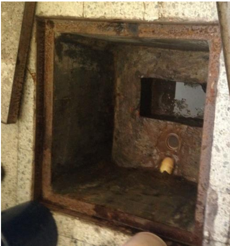
Imagen 2. Segunda Caja de inspección
