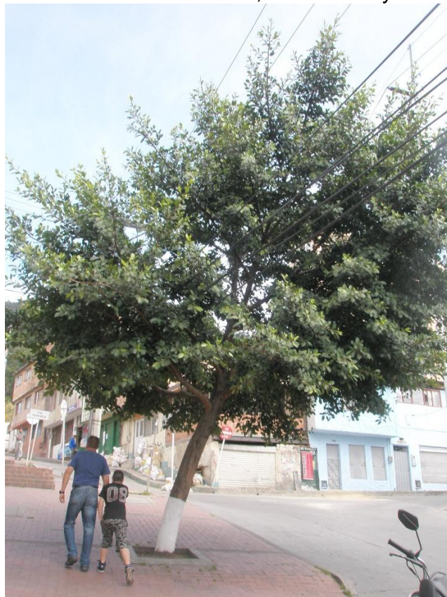
Figura 3. Afectación líneas eléctricas aéreas, Calle 65 No. 1 A – 26 Fotografía: Javier Fernández.
