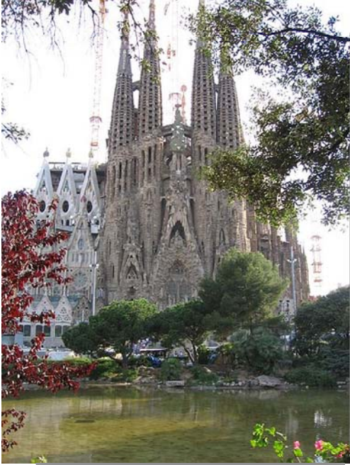
Figura 1. Fachada Templo expiatorio de la Sagrada Familia. Barcelona. Arquitecto Antonio Gaudí.
