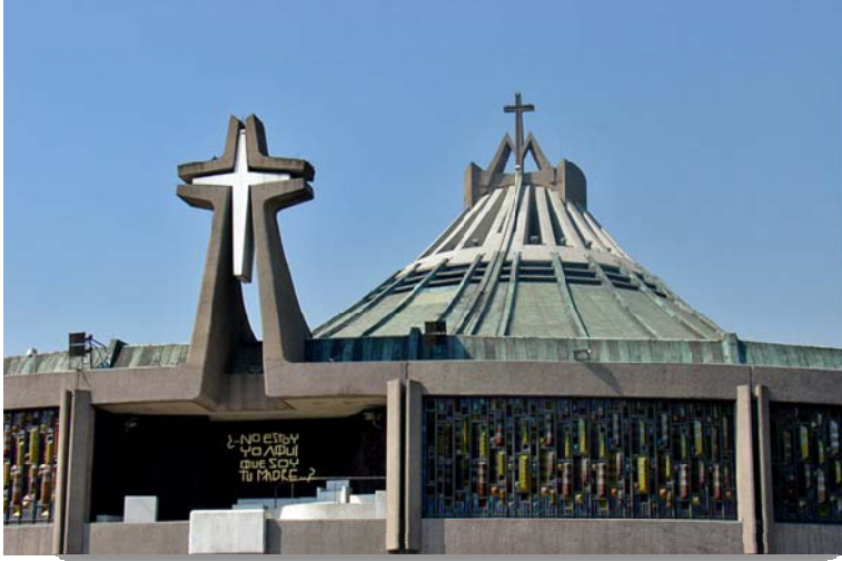
Figura 5. Fachada Basílica Nuestra Sra. De Guadalupe. Arquitecto Pedro Ramírez V.
