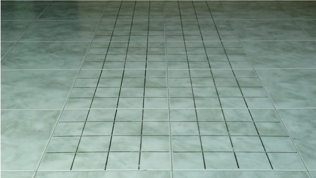
Ilustración 27. Cuadrícula pintada sobre el piso del cuarto de vuelo
