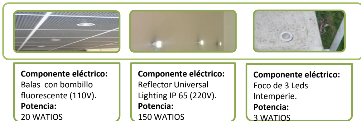
Gráfica 26. Componentes eléctricos de iluminación
