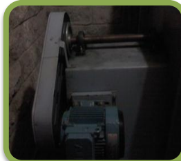
Gráfica 17. Motor del equipo de ventilación
