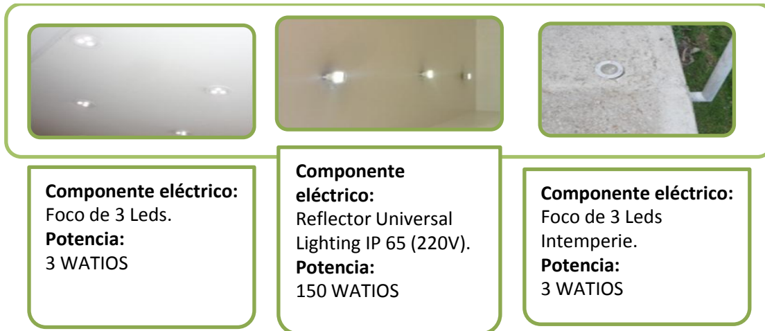
Gráfica 25. Componentes eléctricos de iluminación
