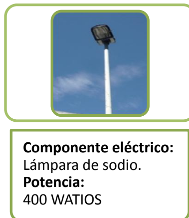
Gráfica 26. Componentes eléctricos de iluminación
