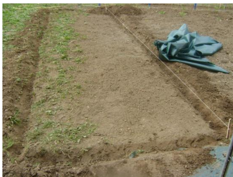
Imagen 14. Área rectangular con zanjas para drenaje
