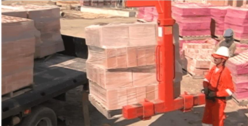
Ilustración 44 Fotografía de diseño de embalaje propuesto
