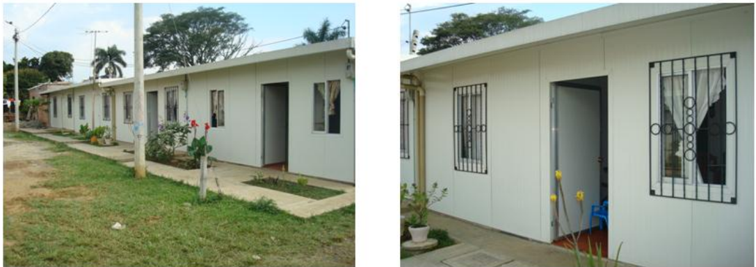
Figura 7. Viviendas de interés social construidas con el sistema METECNO
