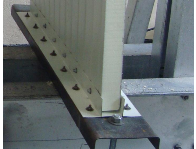
Figura 43. Aseguramiento del montaje
