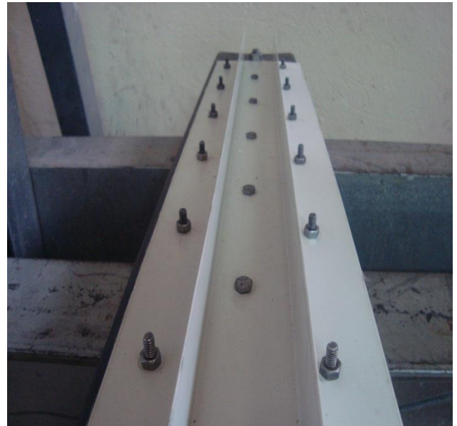
Figura 39. Unión de los remates en U con canales en acero
