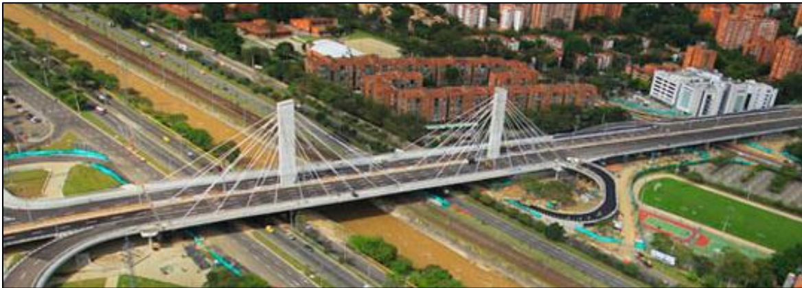
Figura N° 8: Fotografía Puente 4-Sur (El Colombiano, 2013)
