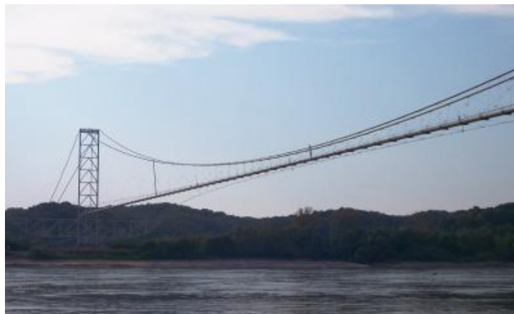
Imagen 2.4 Paso aéreo Grand Tower, entre Illinois-Missouri. Tomado de Baughn, J. (2008)
