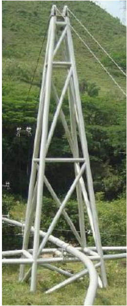
Imagen 4.6 Configuración de torre con elementos verticales inclinados. Foto suministrada por Beltrán F.E
